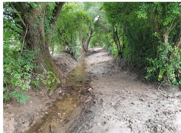
Nach der Maßnahme besitzt der Graben ein deutlich größeres Retentionsvolumen. Es muss jetzt beobachtet werden, ob die Maßnahme ausreicht, um bei Starkregen die Situation zu verbessern.
